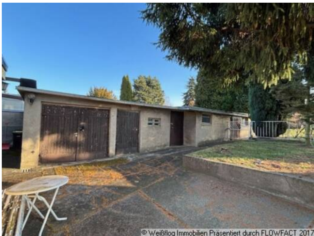
Garage mit Nebenglass
